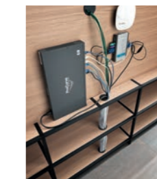
en_TV module electrification it_Elettrificazione modulo porta TV fr_Électrification du module meuble TV
